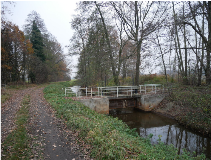
Malxe-Neiße-Kanal Fotograf/Urheber: Kirsten Krepelin
