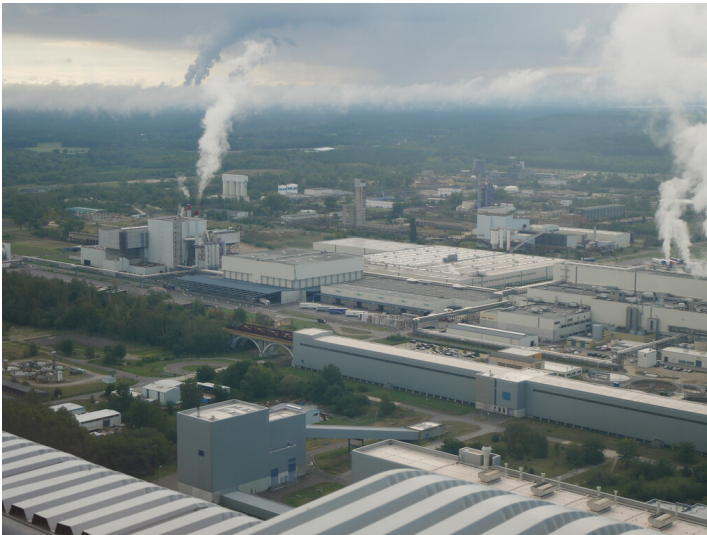
Rohkohlebunker Ost Fotograf/Urheber: Franz Dietzmann
