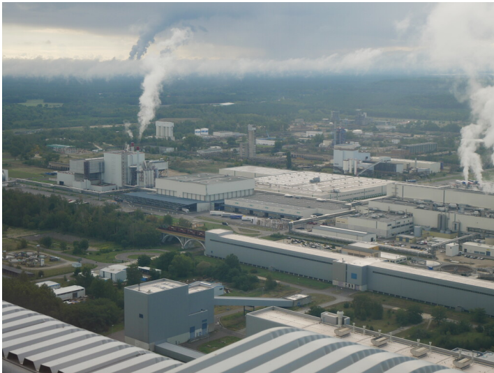
Rohkohlebunker Ost Fotograf/Urheber: Franz Dietzmann
