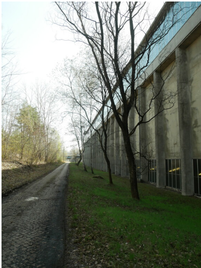
Rohkohlebunker West Fotograf/Urheber: Franz Dietzmann
