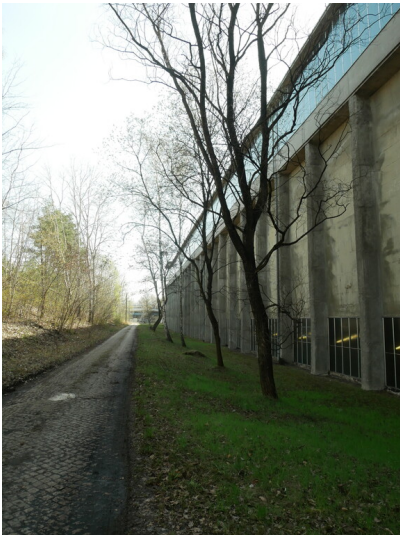
Rohkohlebunker West Fotograf/Urheber: Franz Dietzmann
