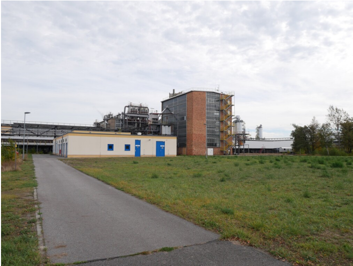
Durchlaufbunker West Fotograf/Urheber: Kaja Boelcke
