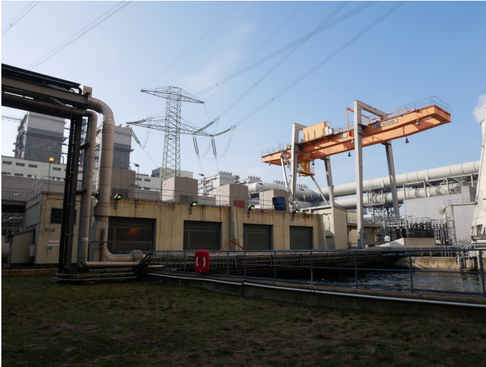
Kraftwerk Jämschwalde Kühlwasserpumpstation (2023) Fotograf/Urheber: Tanja Trittel
