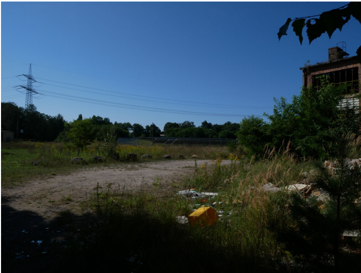
Fabrikhalle Fotograf/Urheber: Franz Dietzmann
