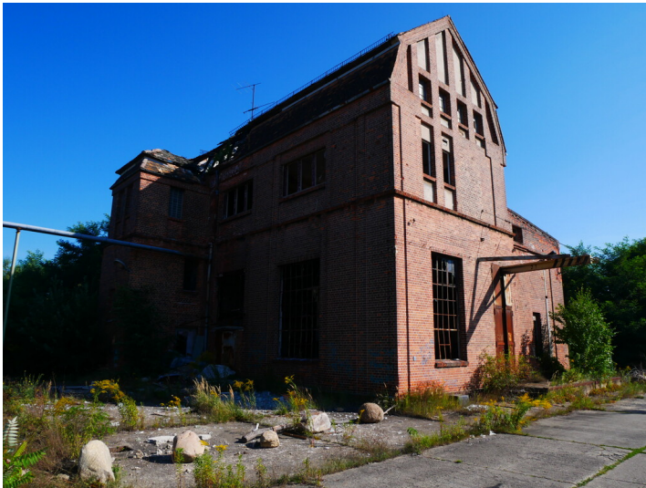
20-kV-Schaltheis Fotograf/Urheber: Franz Dietzmann
