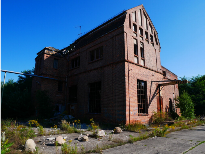
20-kV-Schaltheis Fotograf/Urheber: Franz Dietzmann
