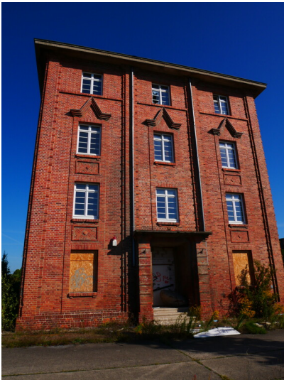
Verwaltungsgebäude Fotograf/Urheber: Franz Dietzmann
