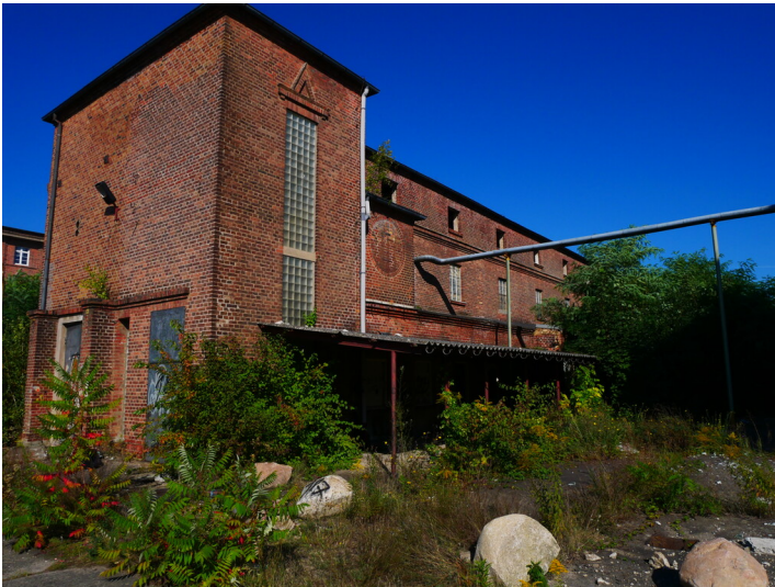
6-kV-Schaltheis Fotograf/Urheber: Franz Dietzmann
