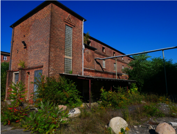
6-kV-Schaltheis Fotograf/Urheber: Franz Dietzmann
