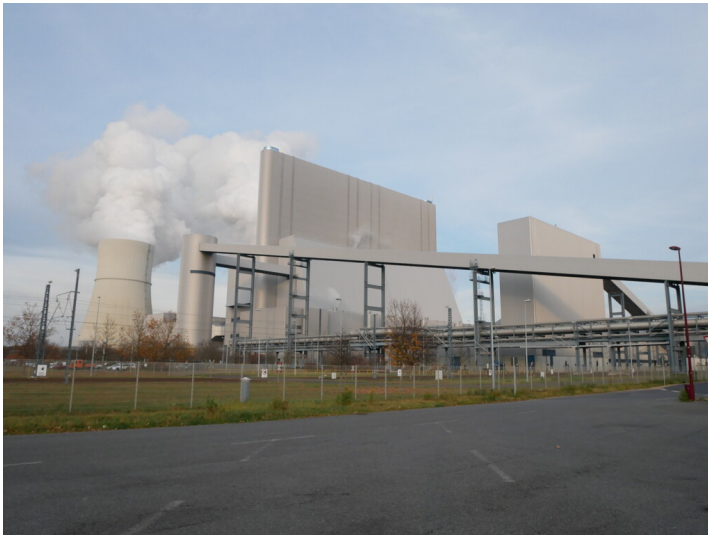
Kraftwerk Schwarze Pumpe Fotograf/Urheber: Kaja Boelcke
