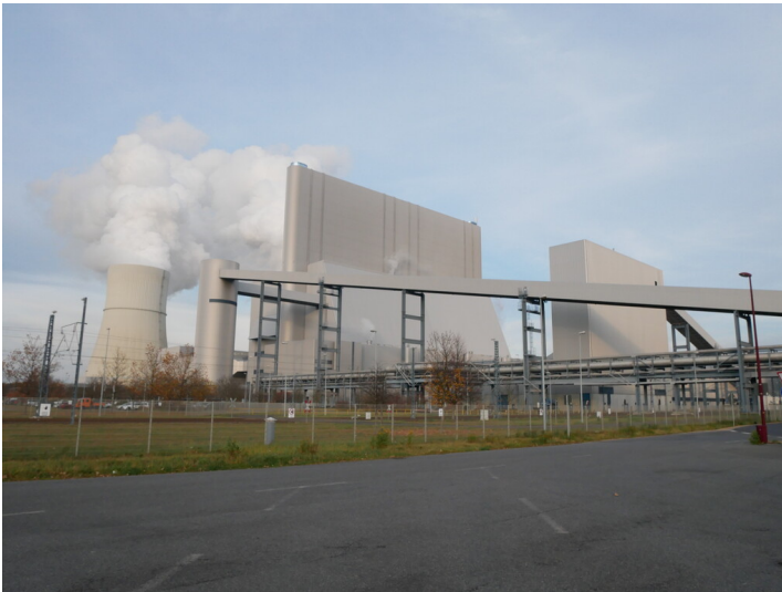
Kraftwerk Schwarze Pumpe Fotograf/Urheber: Kaja Boelcke
