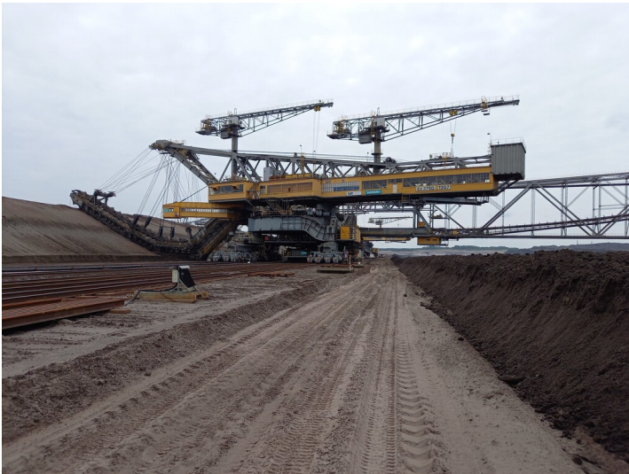
Eimerkettenbagger Es 3750 1307 Fotograf/Urheber: Marie Mamerow
