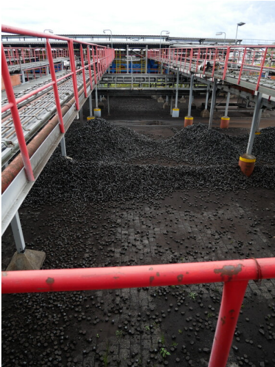
Rinnen- und Kühlschranksanlage Fotograf/Urheber: Kirsten Krepelin
