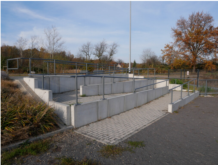
Flutungspunkt Tagebau Cottbus Nord Fotograf/Urheber: Kirsten Krepelin
