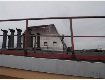
Schlote für den abziehenden Dampf auf dem Dach.
