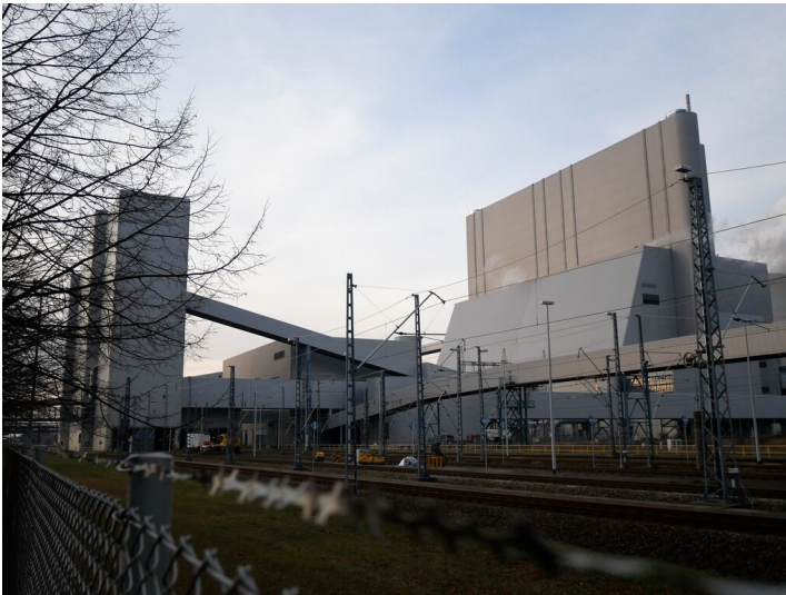
Kalkstein-, Gips- und Ascheförderung Fotograf/Urheber: Kaja Boelcke
