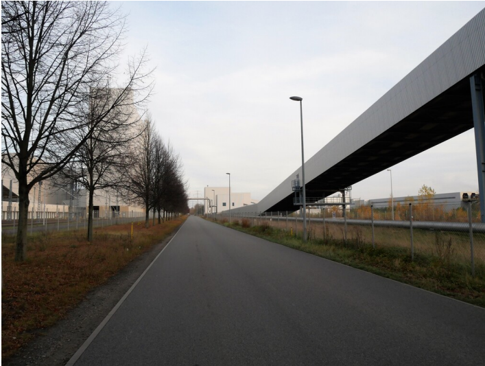
Förderbrücke Fotograf/Urheber: Kaja Boelcke
