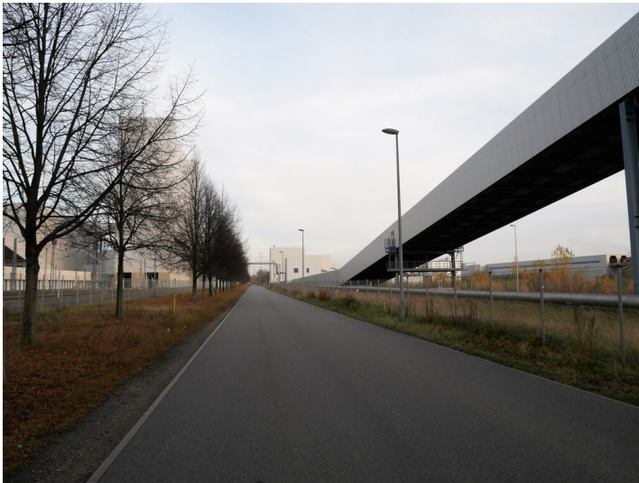
Förderbrücke Fotograf/Urheber: Kaja Boelcke
