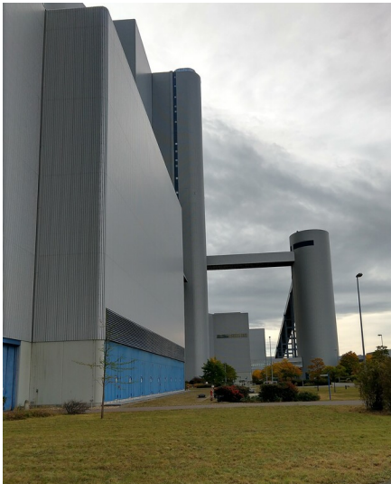
Schaltanlagegebäude REA/E-Filter Fotograf/Urheber: Louise Warnow
