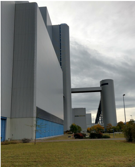
Schaltanlagegebäude REA/E-Filter Fotograf/Urheber: Louise Warnow
