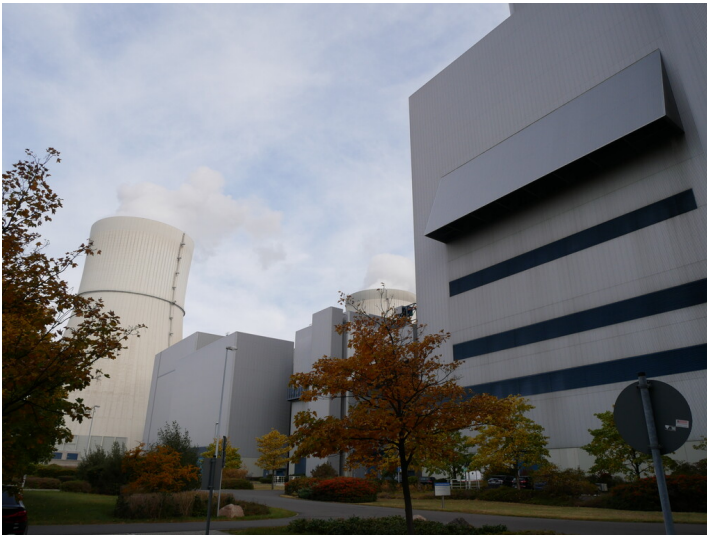
Rauchgasentschwefelung Fotograf/Urheber: Kaja Boelcke
