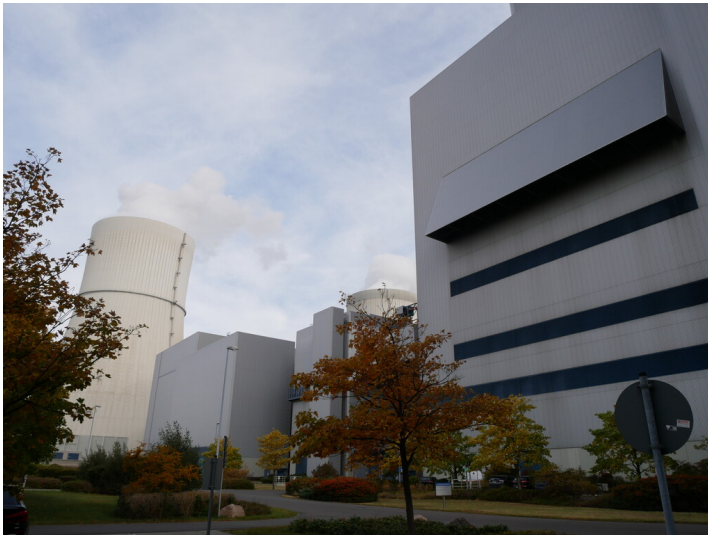
Rauchgasentschwefelung Fotograf/Urheber: Kaja Boelcke
