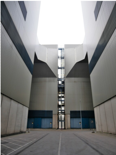
Rauchgasableitung Fotograf/Urheber: Kaja Boelcke
