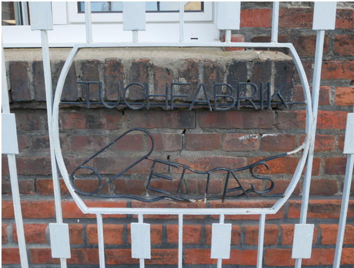
Hauptgebäude der Tuchfabrik C.S. Elias Fotograf/Urheber: Kaja Boelcke
