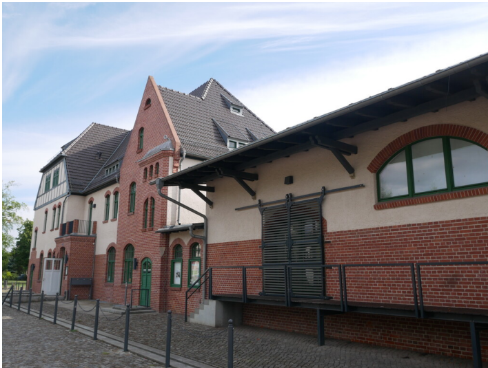
Bahnhof Welzow Fotograf/Urheber: Kaja Boelcke
