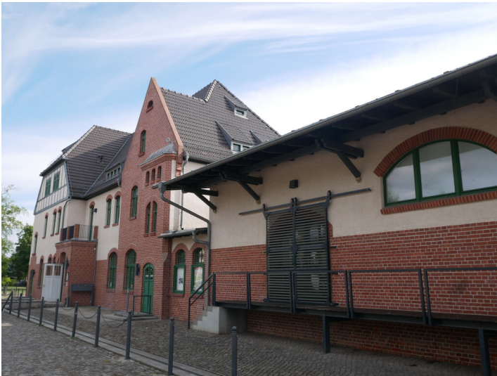
Bahnhof Welzow Fotograf/Urheber: Kaja Boelcke
