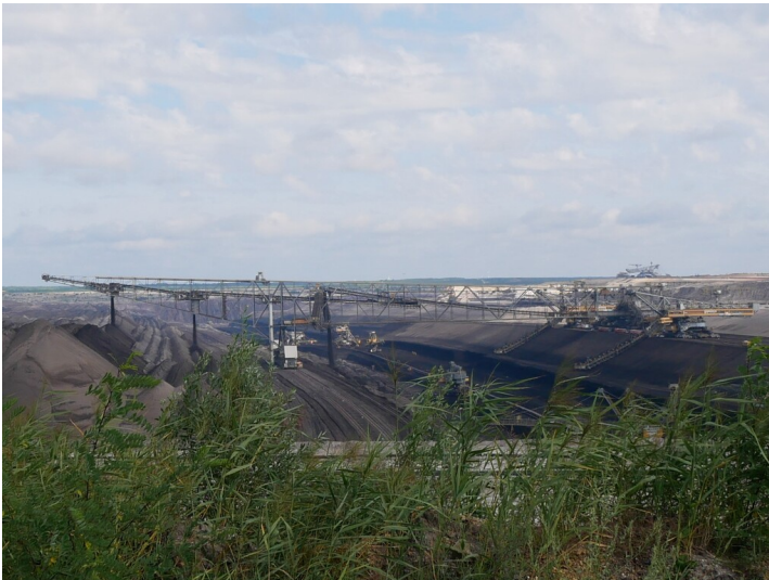
Abraumförderbrücke F60 Nr. 32 Fotograf/Urheber: Kirsten Krepelin
