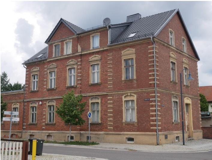
Postgebäude Welzow Fotograf/Urheber: Dr. Barbara Kündiger
