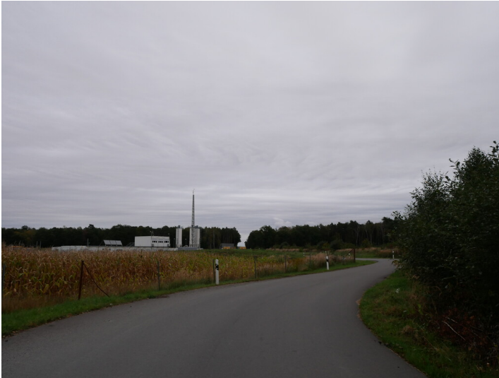
Dichtwand Tagebau Welzow-Süd Fotograf/Urheber: Franz Dietzmann
