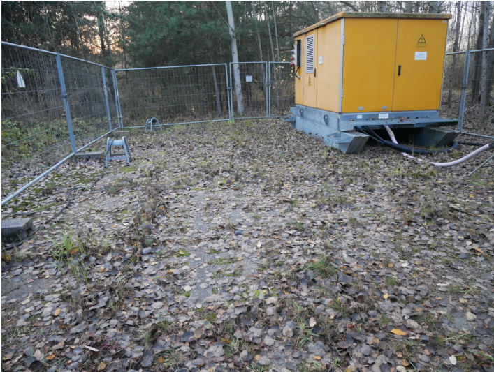
Wasserhaltungsschacht 2 Fotograf/Urheber: Kaja Boelcke
