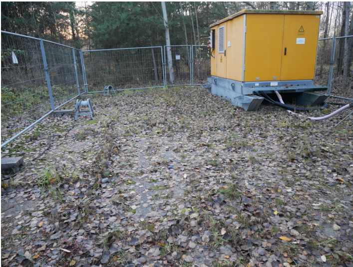
Wasserhaltungsschacht 2 Fotograf/Urheber: Kaja Boelcke
