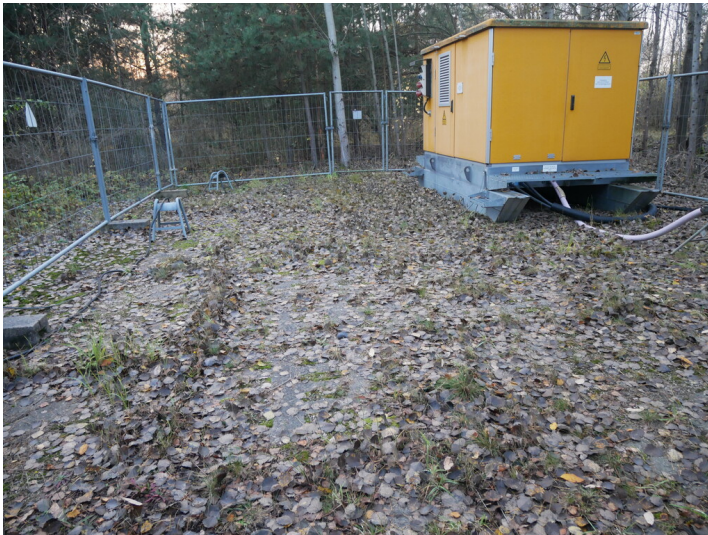
Wasserhaltungsschacht 2 Fotograf/Urheber: Kaja Boelcke
