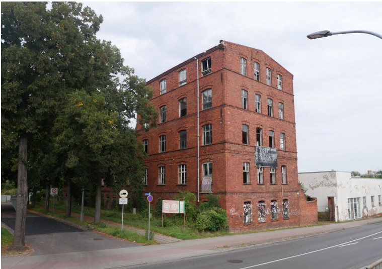
Tuchfabrik Adolf Sinapius Fotograf/Urheber: Franz Dietzmann
