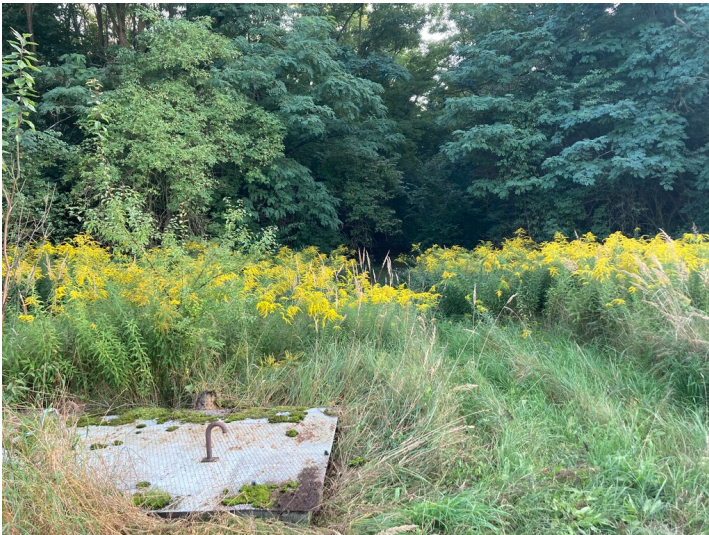
Schacht Grube Anna Fotograf/Urheber: Kaja Boelcke
