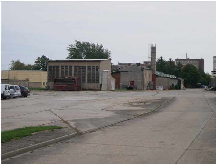
Kohlebahnhof Spremberg Fotograf/Urheber: Franz Dietzmann
