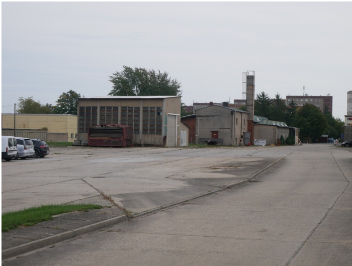
Kohlebahnhof Spremberg Fotograf/Urheber: Franz Dietzmann
