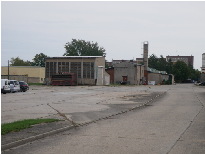
Kohlebahnhof Spremberg Fotograf/Urheber: Franz Dietzmann
