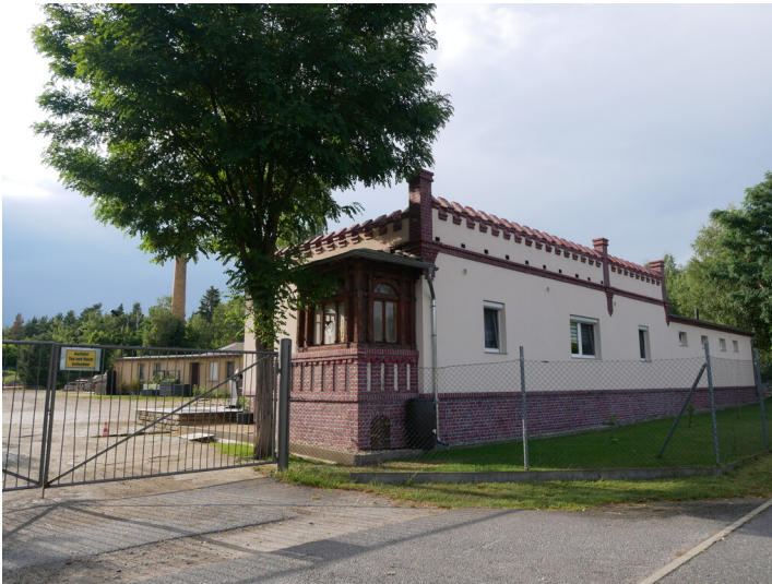
Fabrikgelände Steudel Fotograf/Urheber: Dr. Barbara Kündiger
