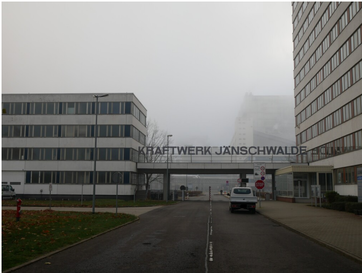
Kraftwerk Jänschwalde Fotograf/Urheber: Kaja Boelcke
