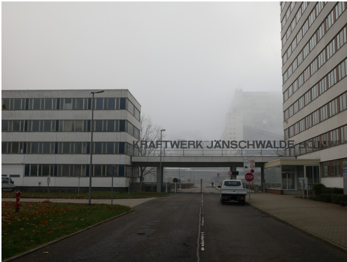
Kraftwerk Jänschwalde Fotograf/Urheber: Kaja Boelcke
