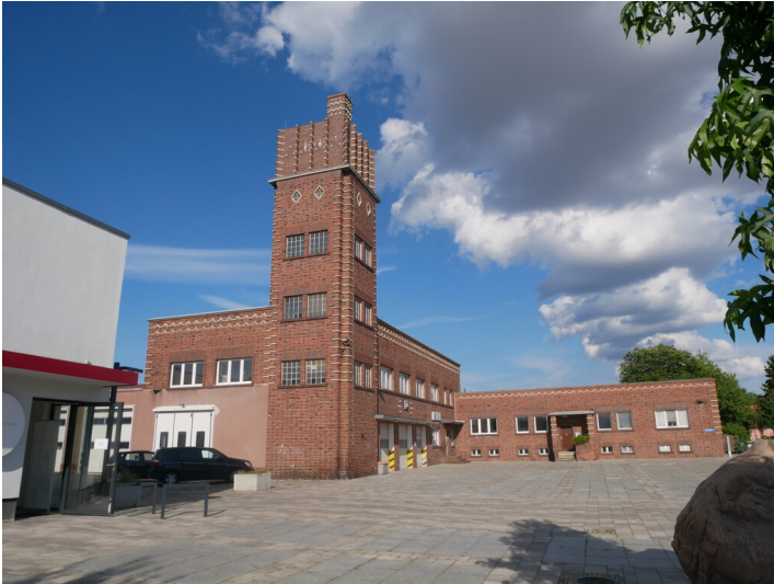
Feuerwehrdepot mit Wohntrakt Fotograf/Urheber: Kaja Boelcke
