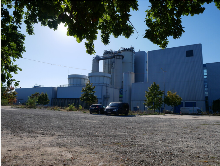
Heizkraftwerk Cottbus Fotograf/Urheber: Kaja Boelcke
