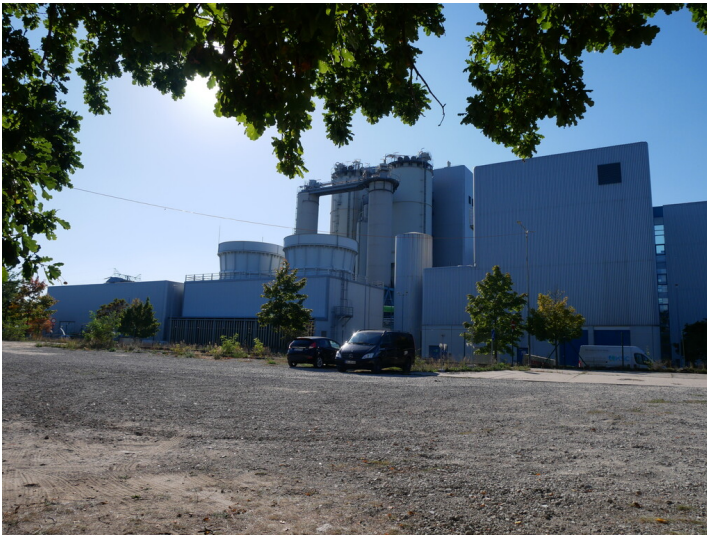
Heizkraftwerk Cottbus Fotograf/Urheber: Kaja Boelcke
