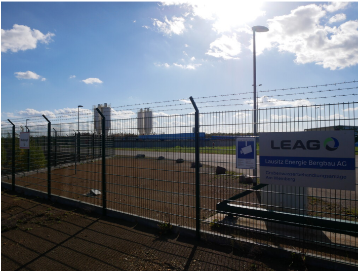
Grubenabwasserbehandlungsanlage Am Weinberg Fotograf/Urheber: Franz Dietzmann
