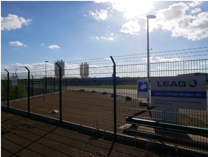
Grubenabwasserbehandlungsanlage Am Weinberg Fotograf/Urheber: Franz Dietzmann
