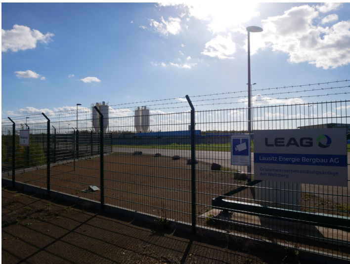
Grubenabwasserbehandlungsanlage Am Weinberg Fotograf/Urheber: Franz Dietzmann
