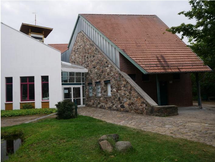
Bürgerhaus Kausche Fotograf/Urheber: Louise Warnow
