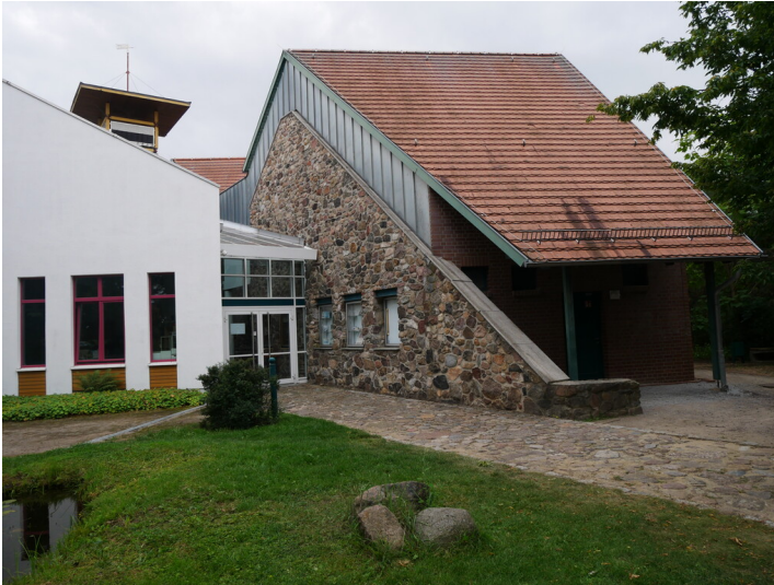
Bürgerhaus Kausche Fotograf/Urheber: Louise Warnow
