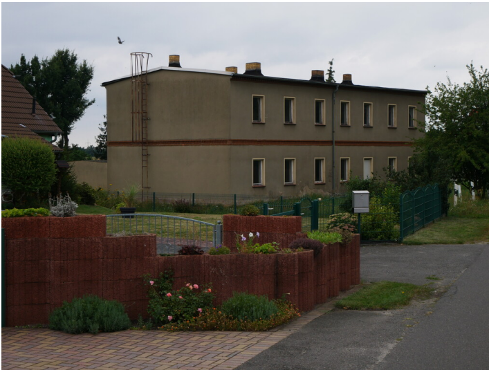
Kontorgebäude Brikettfabrik Merkur Fotograf/Urheber: Franz Dietzmann
