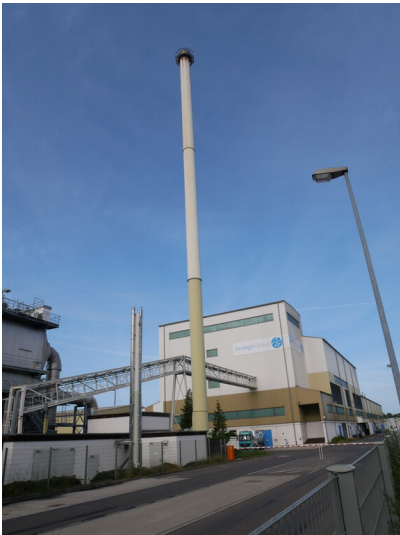
Ardagh-Group Glaswerk Drebkau Fotograf/Urheber: Kaja Boelcke
