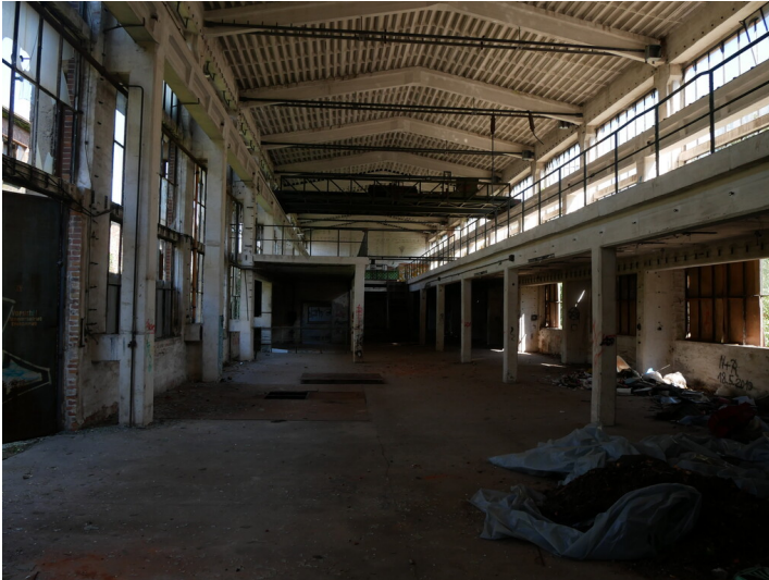
Hallenkran im Kraftwerk Trattendorf Fotograf/Urheber: Franz Dietzmann
