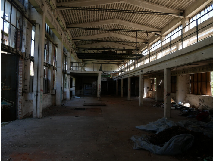
Hallenkran im Kraftwerk Trattendorf Fotograf/Urheber: Franz Dietzmann
