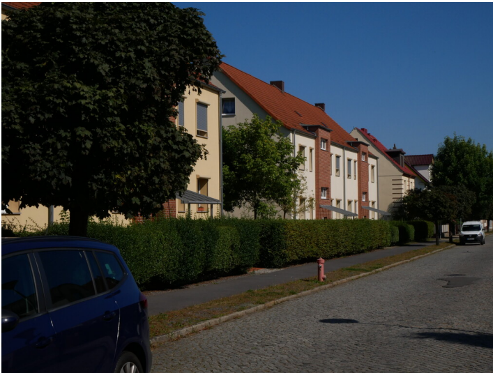
Wohnbauten Heinrichsfelder Allee Fotograf/Urheber: Franz Dietzmann
