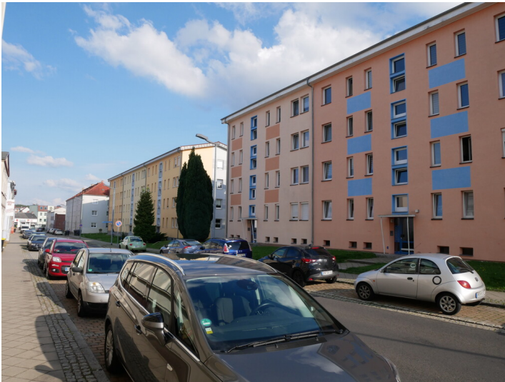
Wohnhäuser Leipziger & Berliner Str. Fotograf/Urheber: Franz Dietzmann
