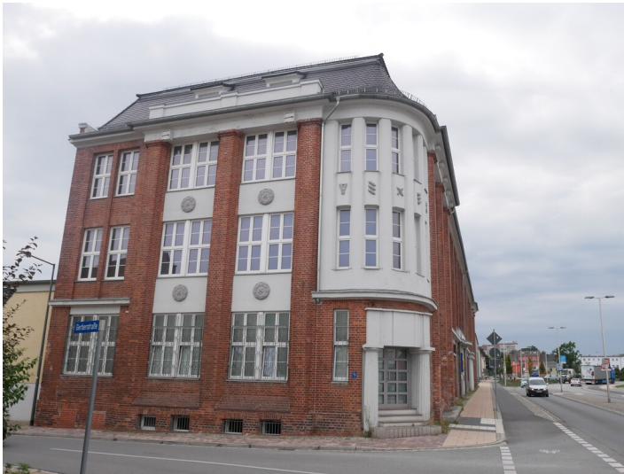
Tuchfabrik C. A. Krüger Fotograf/Urheber: Franz Dietzmann
