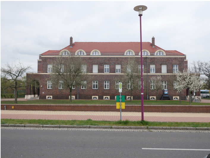
Beamtenwohnhaus der Ilse-Bergbau-AG Fotograf/Urheber: Kaja Boelcke
