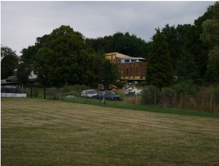
Brikettfabrik Merkur Fotograf/Urheber: Franz Dietzmann
