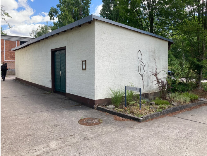
Gesteinslabor des ehemaligen Braunkohlenwerks Dölitz, Blick von Westen. Fotograf/Urheber: Christian Schmidt
