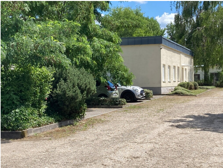
Tränkanlage des ehemaligen Braunkohlenwerks Dölitz, Blick von Norden. Fotograf/Urheber: Christian Schmidt
