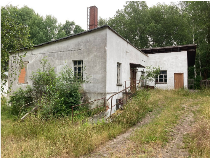
Ehemaliges Pressenhaus im Nordwerk des Königlich-Sächsischen Braunkohlenwerks Leipzig, Blick von Westen. Fotograf/Urheber: Christian Schmidt
