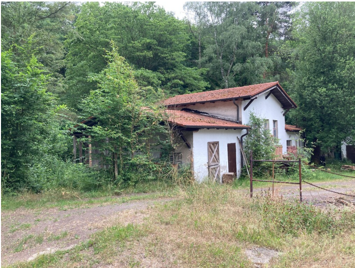
Ehemalige Kaue im Nordwerk des Königlich-Sächsischen Braunkohlenwerks Leipzig, Blick von Nordosten. Fotograf/Urheber: Christian Schmidt
