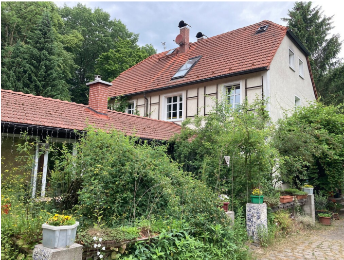
Ehemaliges Huthaus im Nordwerk des Königlich-Sächsischen Braunkohlenwerks Leipzig, Blick von Süden. Fotograf/Urheber: Christian Schmidt
