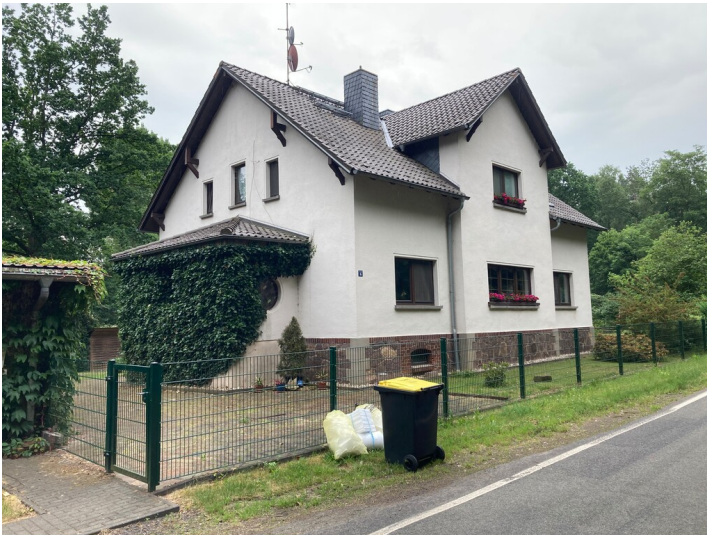
Ehemaliges Direktorenvilla des Königlichen Braunkohlenwerks am Hühnerborn, Blick von Nordwesten. Fotograf/Urheber: Christian Schmidt
