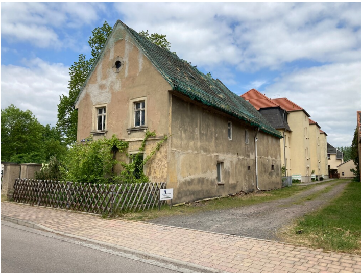
Industriedorf Großzössen, Straße des Friedens 10, Blick von Südosten. Fotograf/Urheber: Christian Schmidt
